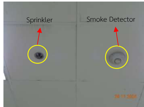
อุปกรณ์ตรวจจับควัน และ Sprinkler
