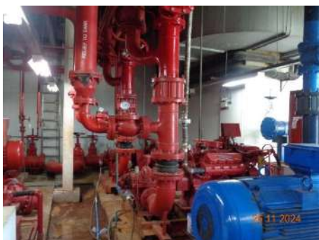
Fire Pump (ระบบเครื่องสูบน้ำดับเพลิง)
