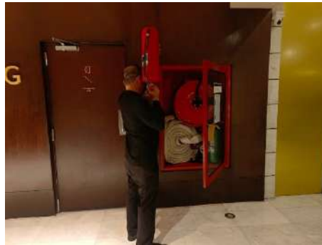
ภาพที่ 2.2-22 การตรวจสอบอุปกรณ์ดับเพลิง
